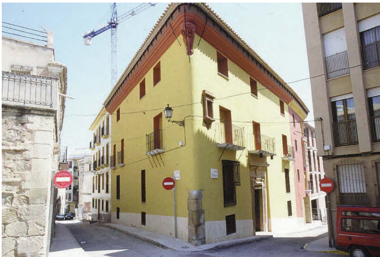
Lámina 1. Fachada de la casa rubira rehabilitada.
