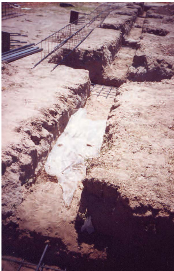
Figura 3. Protección de las estructuras.
