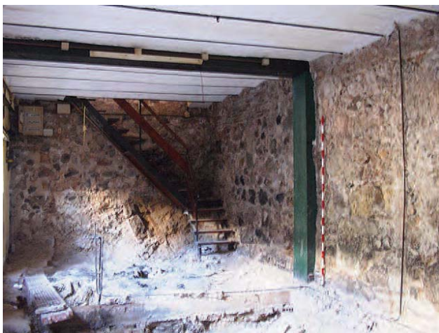
Lámina 1. Vista general del muro sur (a la derecha) y muro este (al fondo) de la habitación de la planta inferior del antiguo Café-bar La Catedral.
