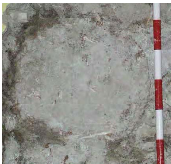
Lámina 4. Fuste de columna n.º 3, situado en el muro sur de la habitación de la planta inferior del antiguo Café-bar La Catedral.
