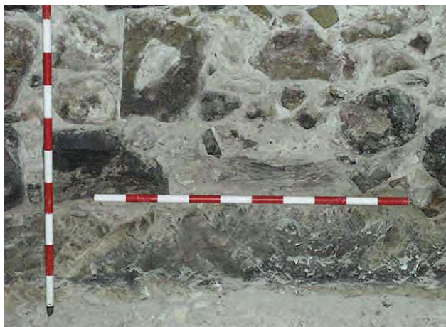
Lámina 5. Detalle de la roca natural y su amortización en la construcción del muro sur de la habitación de la planta inferior del antiguo Café-bar La Catedral.
