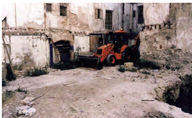
Lámina 1. Início del seguimiento arqueológico en la terraza superior del solar de la calle Mayor n.º 10, esquina calle Andino n.º 2 de Cartagena.
