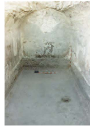
Lámina 3. Reutilización de la cisterna romana nº 1 como vivienda en el s. XVII, en primer término puerta de acceso a la estancia. En la parte central restos del tabique interior que separa la cocina de la alcoba.
