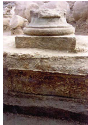
Lámina 44. Detalle de la moldura que corona el podium de la columnata exterior del pórtico.
