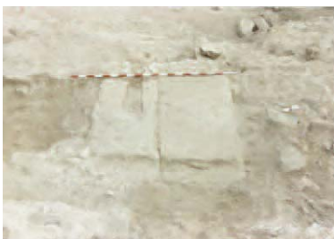
Lámina 18. Detalle del pavimento de la tercera praecinctio realizado con grandes losas de arenisca, probablemente colocadas a soga y tizón.
