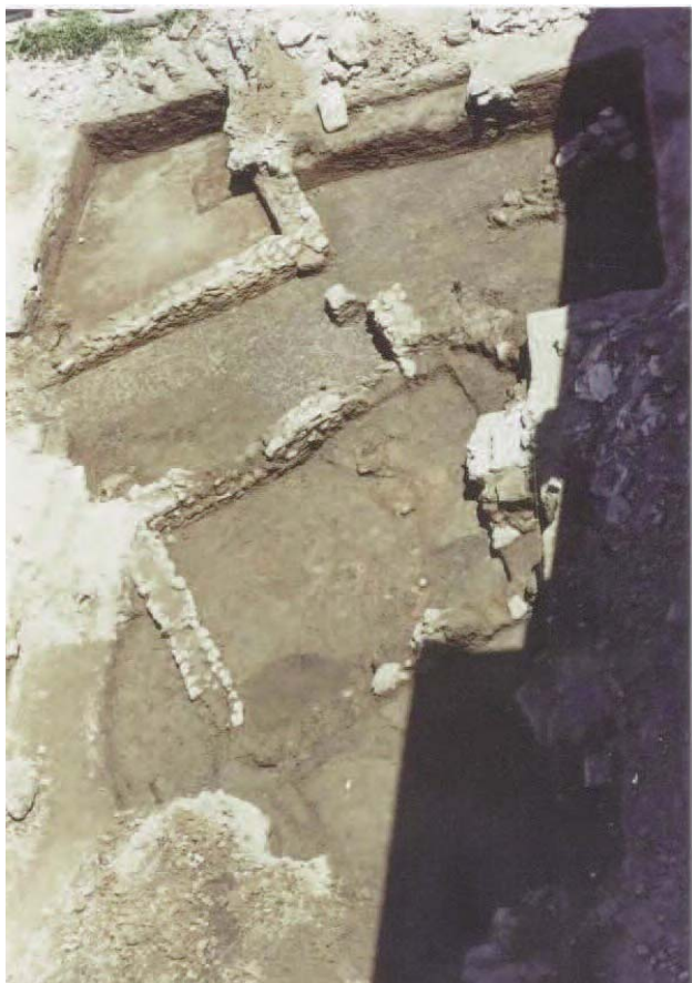
Lámina 1. Vista general de la edificación 1 (vivienda).
