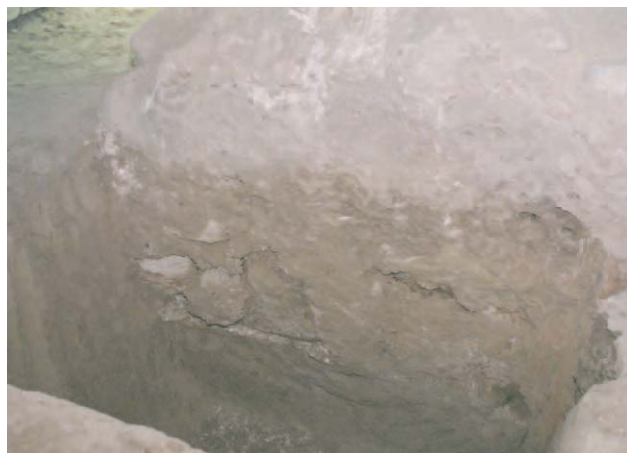
Lámina 18. Cata del interior de la torre.
