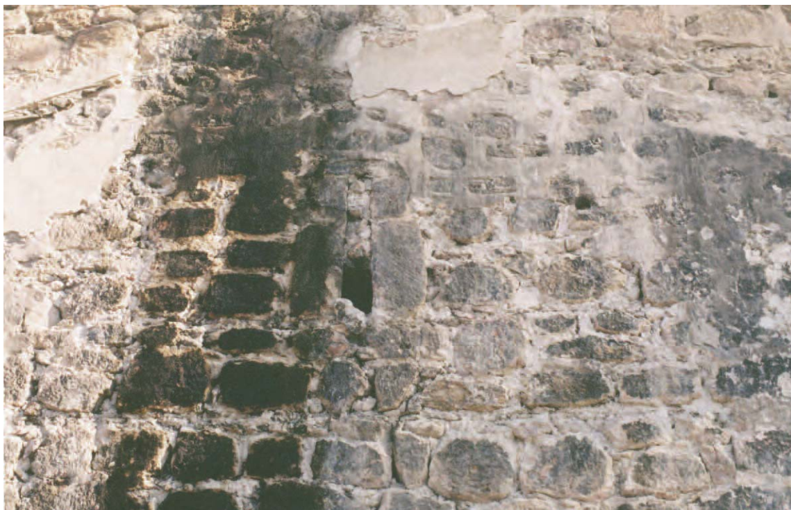
Lámina 5. Imagen de la saetera que apareció tras derruir la casa que estaba apoyada en la pared sur.
