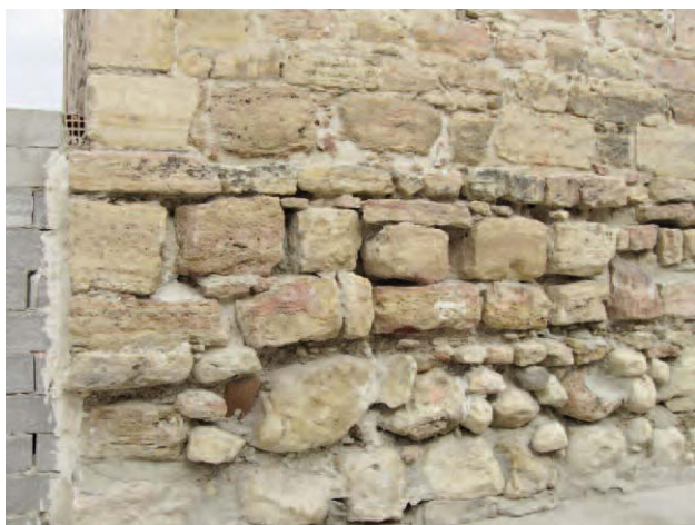
Lámina 2. Los cimientos de la torre quedaron expuestos después del rebaje del terreno.
