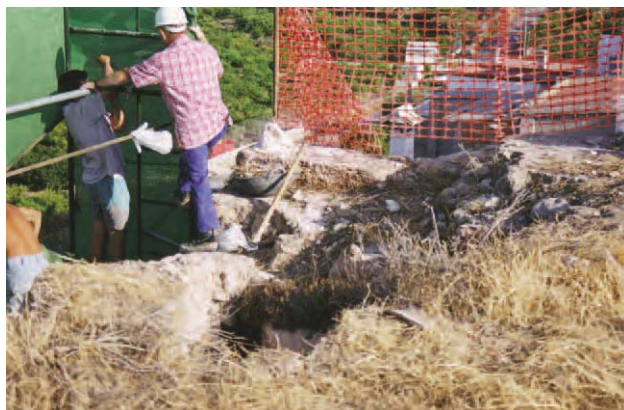
Lámina 21. Comienzo de los trabajos en la terraza.
