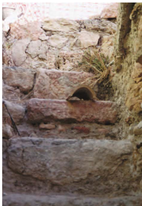
Lámina 9. Detalle del acceso a la terraza desde el interior.
