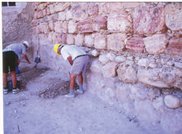
Lámina 13. Comienzo de la cata en la pared oeste que da al río y que sería la de la entrada original.
