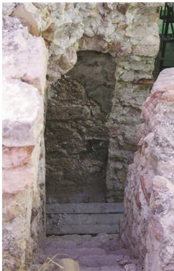
Lámina 8. Escalera de acceso a la terraza.
