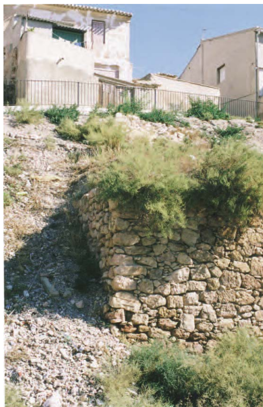
Lámina 12. Detalle de la misma torre.
