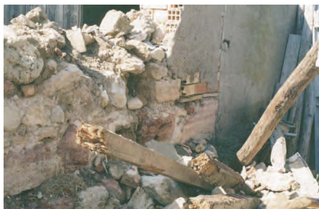
Lámina 19. Restos del gran muro que rodeaba la torre y que se aprovechó como muro medianero para la construcción de una vivienda del pueblo.
