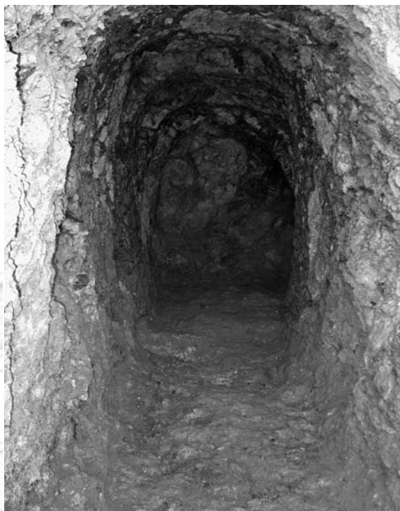
Lámina 2. Detalle del tramo de la galería antigua documentada en Mina Balsa.
