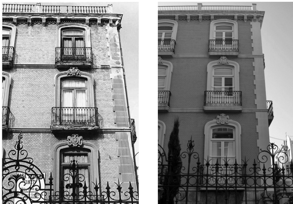
Láminas 4 y 5. Edificio Casa Moreno. Estado anterior y posterior a la rehabilitación.
