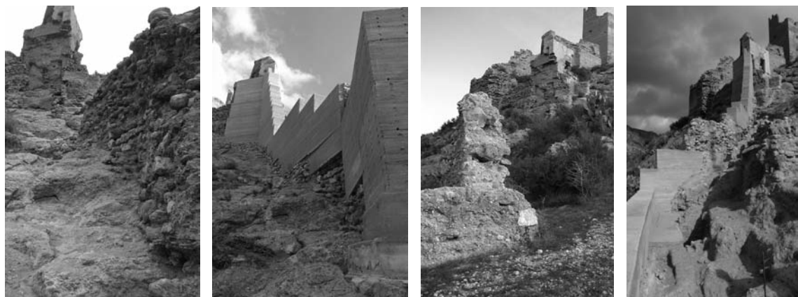
Láminas 3 a 6. Vistas hacia la torre, antes y después de las obras de la primera fase (FJLM).
