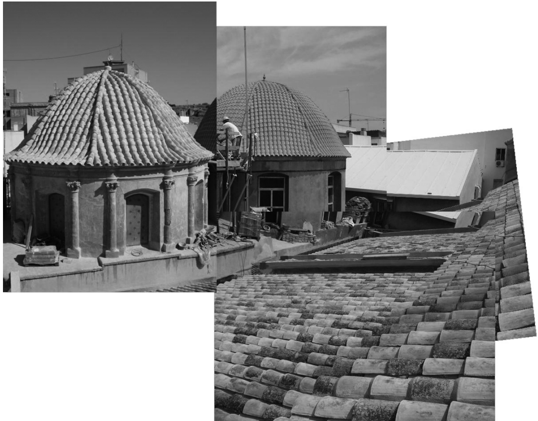
Láminas 7 y 8. Imágenes antes (arriba) y durante el transcurso de las obras en el lateral norte. En la fotografía inferior se aprecian los faldones de cubiertas ya reparados, así como la nueva cobertura de teja de la última capilla (anteriormente cubierta con tela asfáltica acabado gofrado) y el inicio de los trabajos en la anterior (en la fecha de la fotografía ya se han realizado los tajos de cubierta pero aún no estaban iniciados los de los paramentos).
