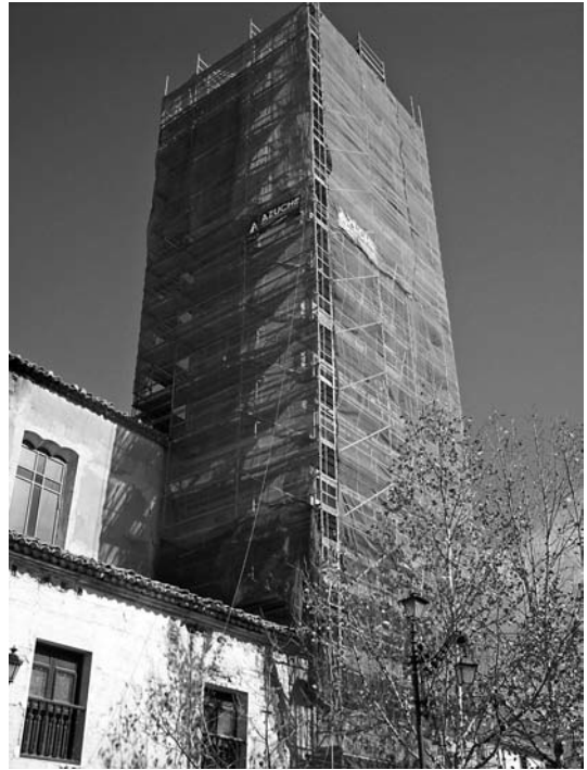
Lámina 7. Andamio instalado para realizar una limpieza superficial en la torre.
