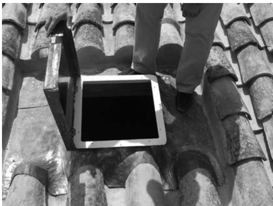
Láminas 12, 13, 14 y 15. Detalle del sistema empleado para asegurar el mantenimiento e inspección de las cubiertas a base de la instalación de trampillas con base de lucernarios, forrados de plomo y, sobre dicho bastidor, colocación de tablero contrachapado y bisagra, todo ello también forrado de plomo.
