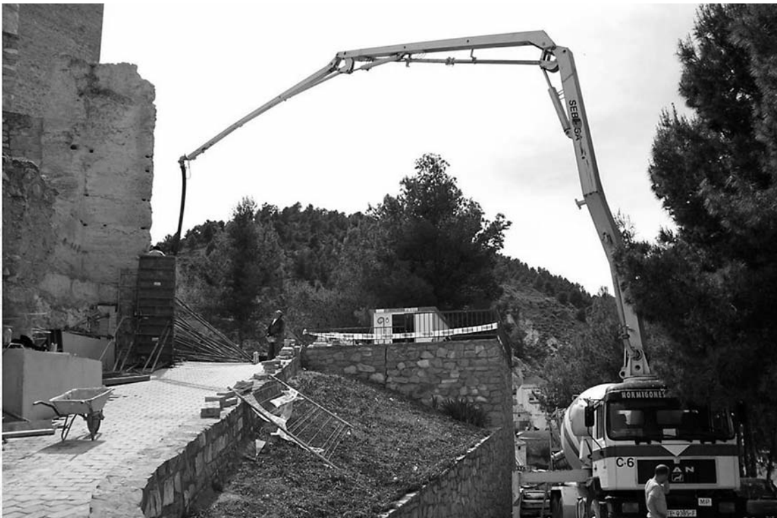
Lámina 6. Hormigonado de cimentación. Para hormigonar 4 \text{ m}^3 en una zona donde no accedían camiones, se utilizó una bomba de hormigón destina a verter grandes volúmenes.
