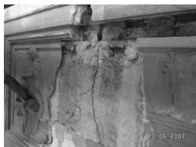
Láminas 10, 11 y 12. Recomposición volumétrica, tratamiento de grietas y estucados.
