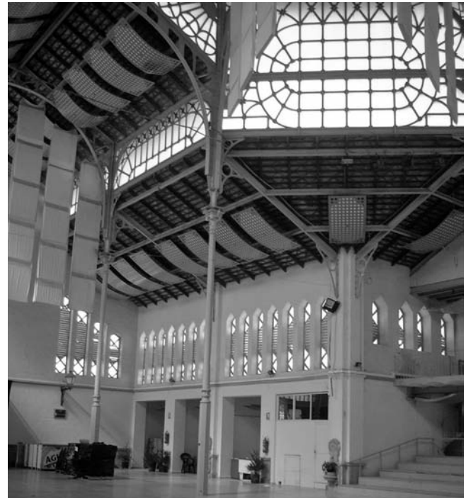
Lámina 6. Vista interior del mercado en la actualidad donde se aprecia la estructura en hierro.
