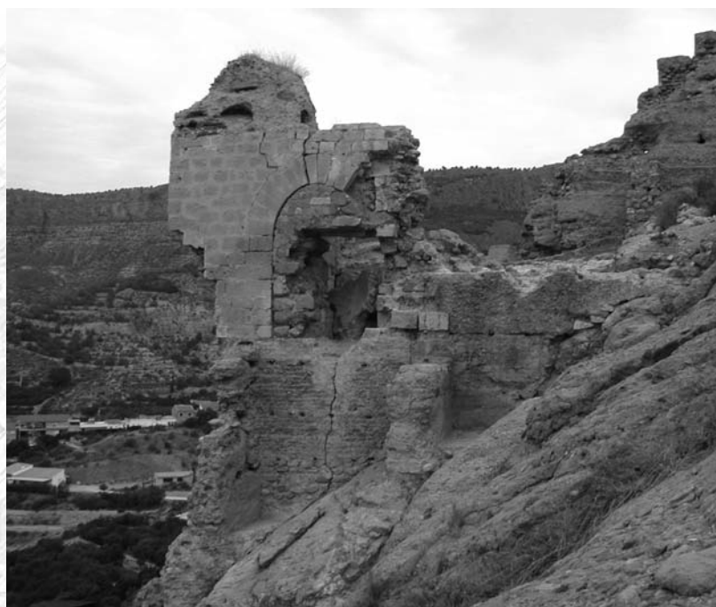
Lámina 1. Castillo de Alhama. Puerta entre los dos recintos en la llamada torre cristiana, vista desde el sur. A la izquierda se puede ver el estado de la esquina suroeste, volada tras la pérdida de las estructuras con las cuales se maclaba (FJLM).
