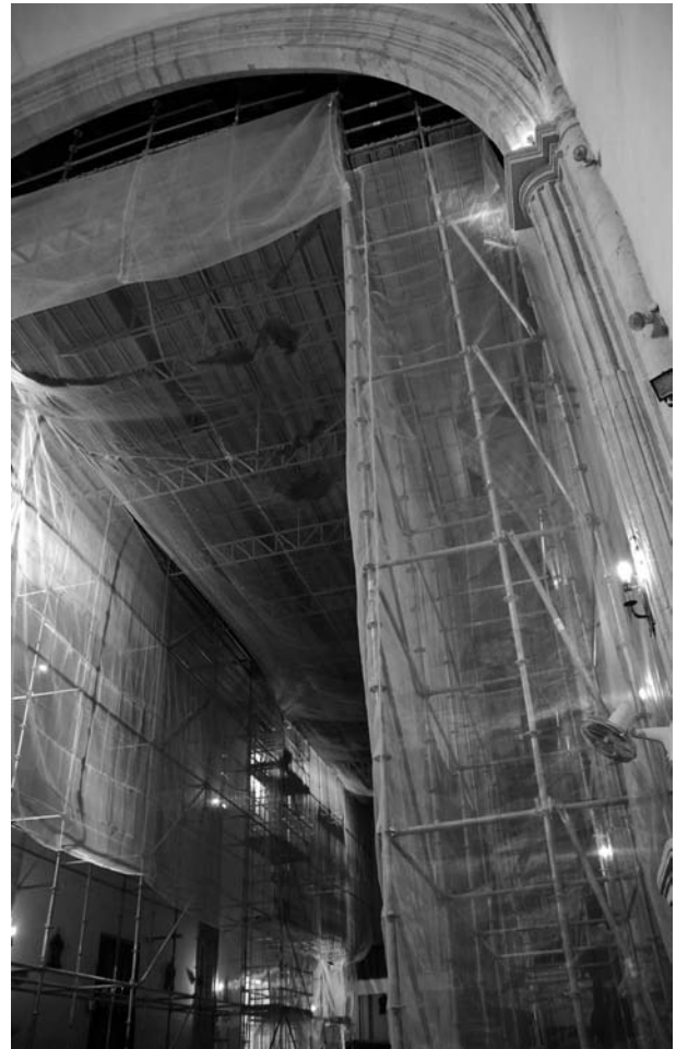
Lámina 4. Andamio colocado para la restauración del artesonado de la iglesia, donde hubo que dejar diáfana la zona de bancos para la celebración de misa.
