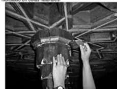
Figura 524. Aplicación del pan de oro fino sobre el primero de los cuerpos que conforman los mocárabes del tramo 1 del almizale de la Concepción.
