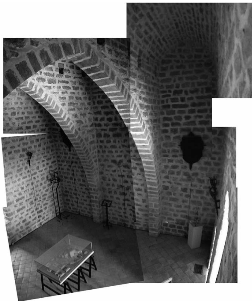
Lámina 3. Interior de la torre del Homenaje, donde se ven los dos arcos ojivales.
