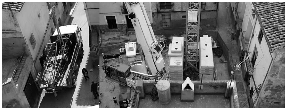
Lámina 1. Vista aérea de plaza en el momento de la instalación de grúa torre.
