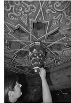
Figura 523. Aplicación del pan de oro fino sobre una de las puntas de los mocárabes del tramo 1 del almizale de la Concepción.
