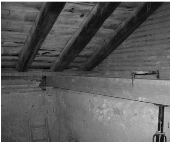
Lámina 11. Detalle de uno de los tirantes rotos de la armadura de madera (arriba) y del laminado del mismo mediante prótesis de madera encoladas con resorcina
