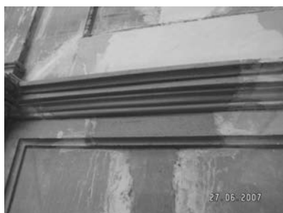
Láminas 10, 11 y 12. Recomposición volumétrica, tratamiento de grietas y estucados.
