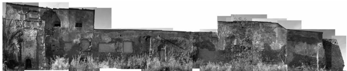
Lámina 3. Fotomontaje del estado de conservación previo a la actuación del alzado este.
