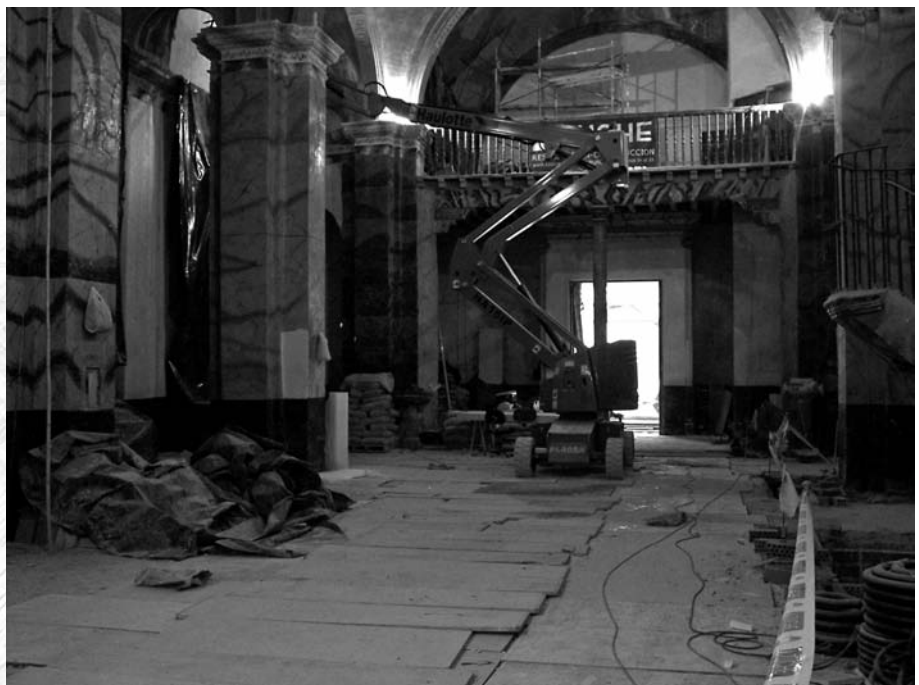
Lámina 3. Cesta articulada en el interior de iglesia. Se tuvo que considerar a parte de la altura de trabajo, las dimensiones de la puerta, el peso para evitar rotura del pavimento y la no emisión de gases.
