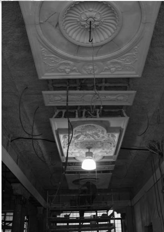
Láminas 21 y 22. Proceso de montaje de los conjuntos ornamentales del salón comedor.
