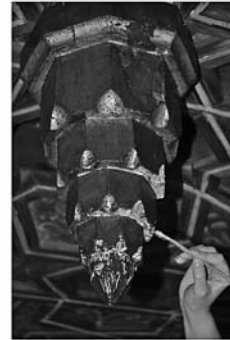
Figura 522. El estudio de las carencias de los mocárabes consistió en emplear el tradicional sistema de sulfato cálcico hidratado en colas naturales.
