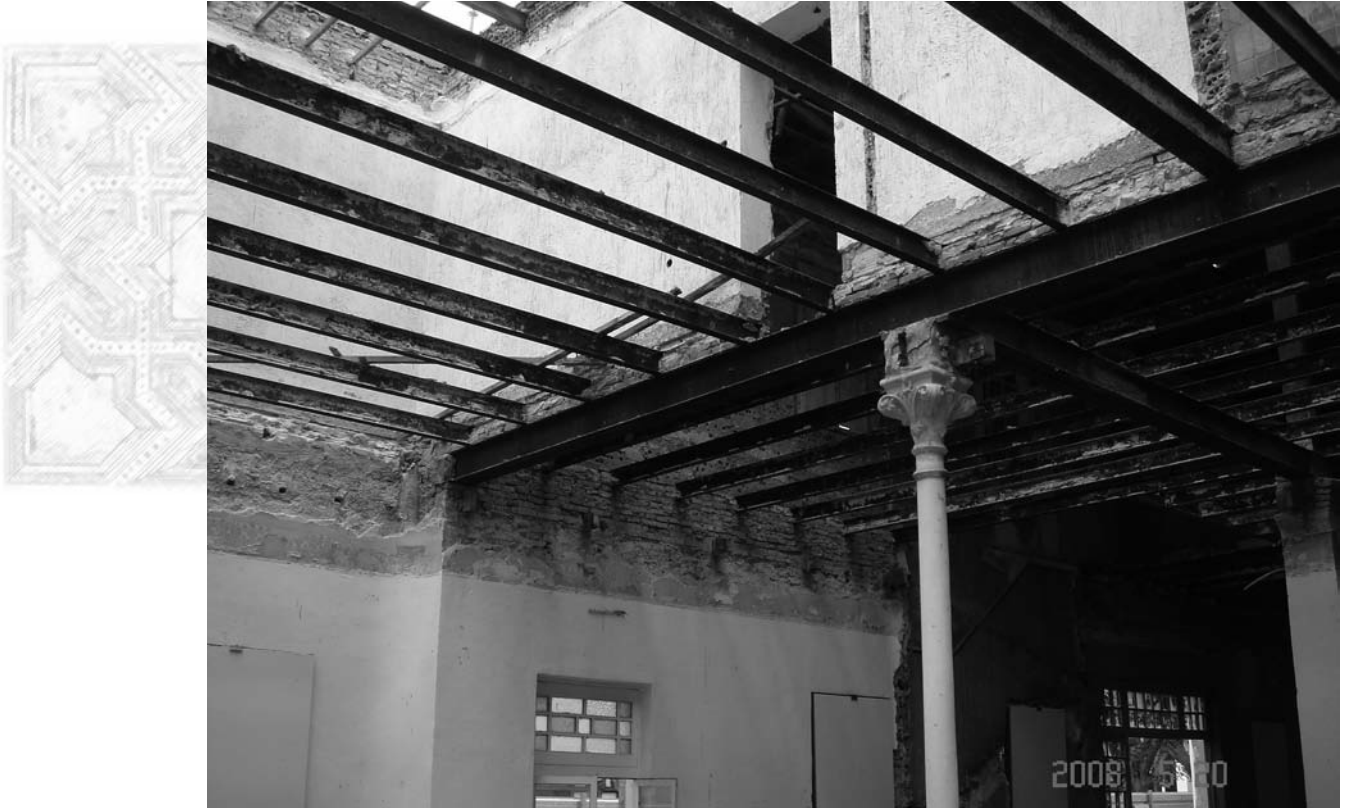
Lámina 2. Detalle del desmontaje de forjado de vigas metálicas en las obras de reforma, acondicionamiento y restauración de la Casa del Niño en Cartagena.
