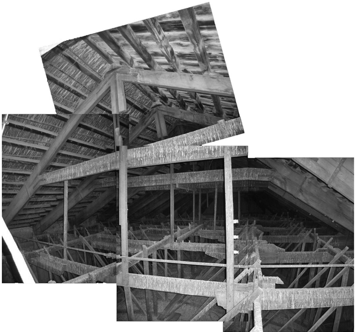
Lámina 4. Estado del espacio bajo la cubierta.
