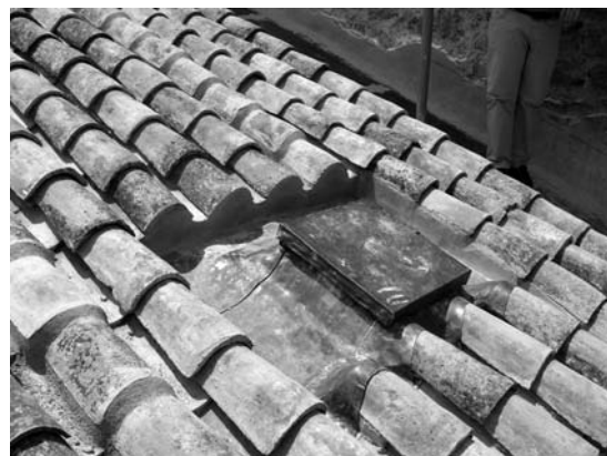
Láminas 12, 13, 14 y 15. Detalle del sistema empleado para asegurar el mantenimiento e inspección de las cubiertas a base de la instalación de trampillas con base de lucernarios, forrados de plomo y, sobre dicho bastidor, colocación de tablero contrachapado y bisagra, todo ello también forrado de plomo.
