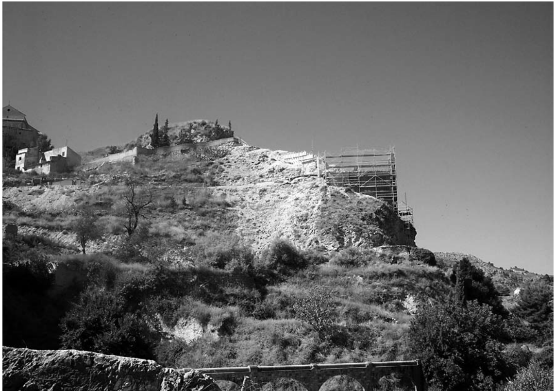
Lámina 8. Andamio instalado en zona inaccesible. Se trasladó el material del andamio 200 m. de forma manual
