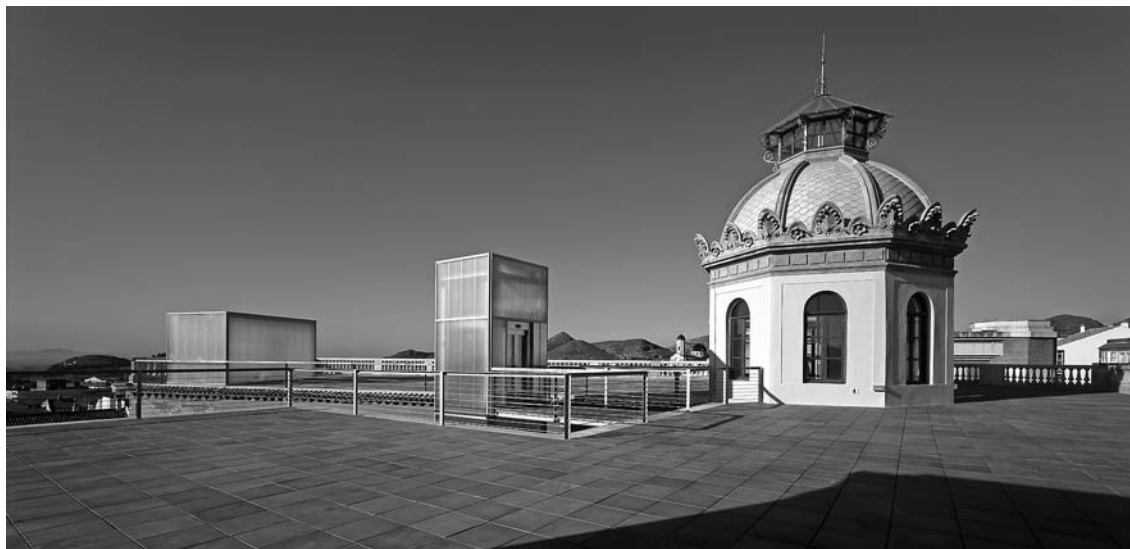
Lámina 6. Imagen de la cubierta con el casetón y la caja del ascensor.
