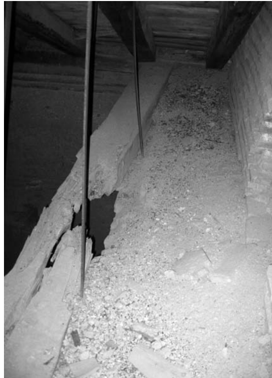
Lámina 11. Detalle de uno de los tirantes rotos de la armadura de madera (arriba) y del laminado del mismo mediante prótesis de madera encoladas con resorcina
