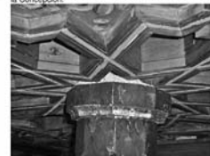
Figura 525. Detalle de cómo queda el primer cuerpo de los mocárabes tras ser reintegrado con el pan de oro fino.
