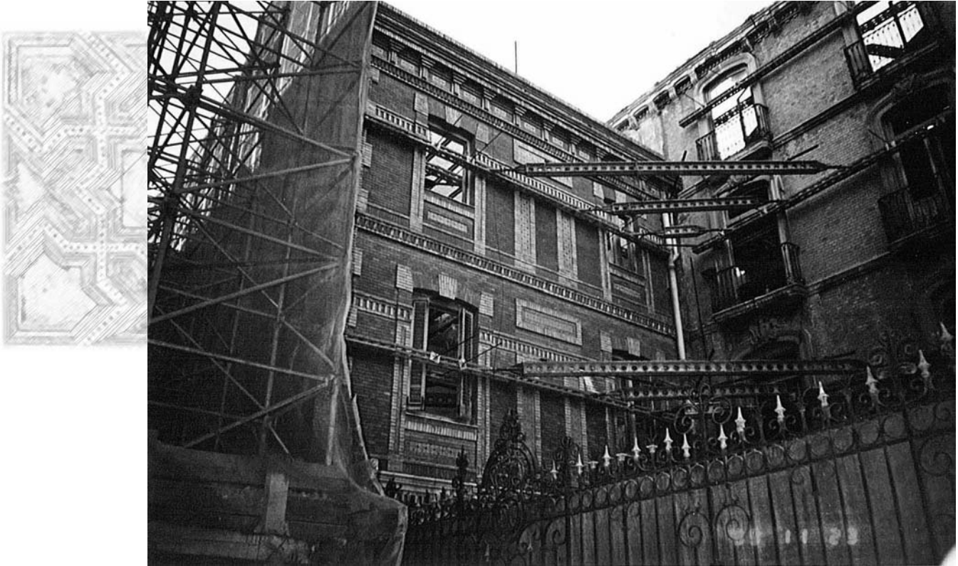
Lámina 1. Edificio Casa Moreno. Apeo de fachadas.
