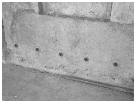
Lámina 8. Aspecto del muro con el electroconvector cerámico colocado (izquierda) y detalle del electroconvector (derecha).
