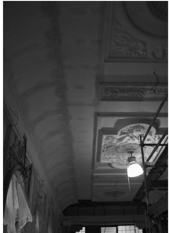
Láminas 21 y 22. Proceso de montaje de los conjuntos ornamentales del salón comedor.
