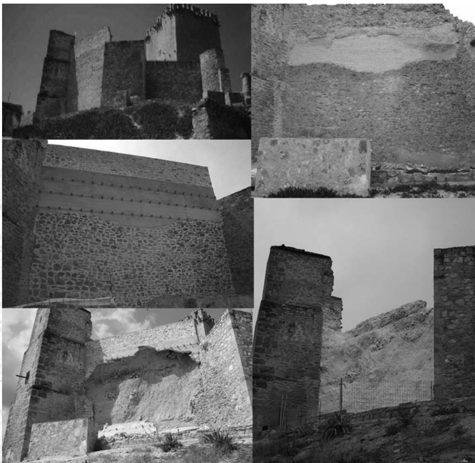
Lámina 8. Imágenes de los diferentes estados del lienzo de muralla comprendido entre la torre de la Magdalena y la torre del Mirador, desplomado en junio de 2007.
