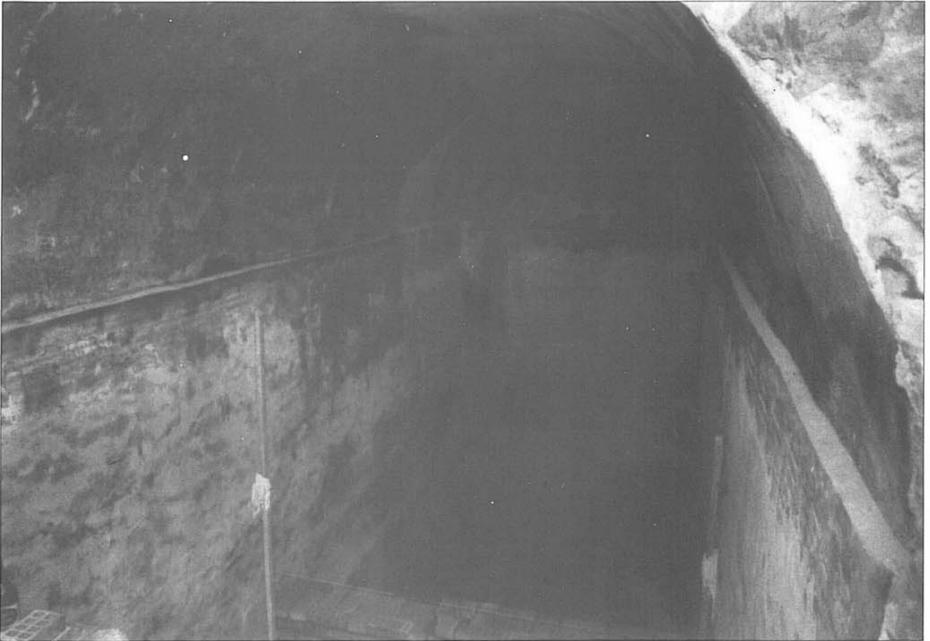
Interior del aljibe donde se aprecian sus grandes dimensiones.
