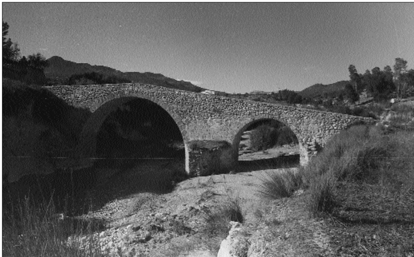
Fig. 3.- Estado del Puente de Hellín antes del accidente
