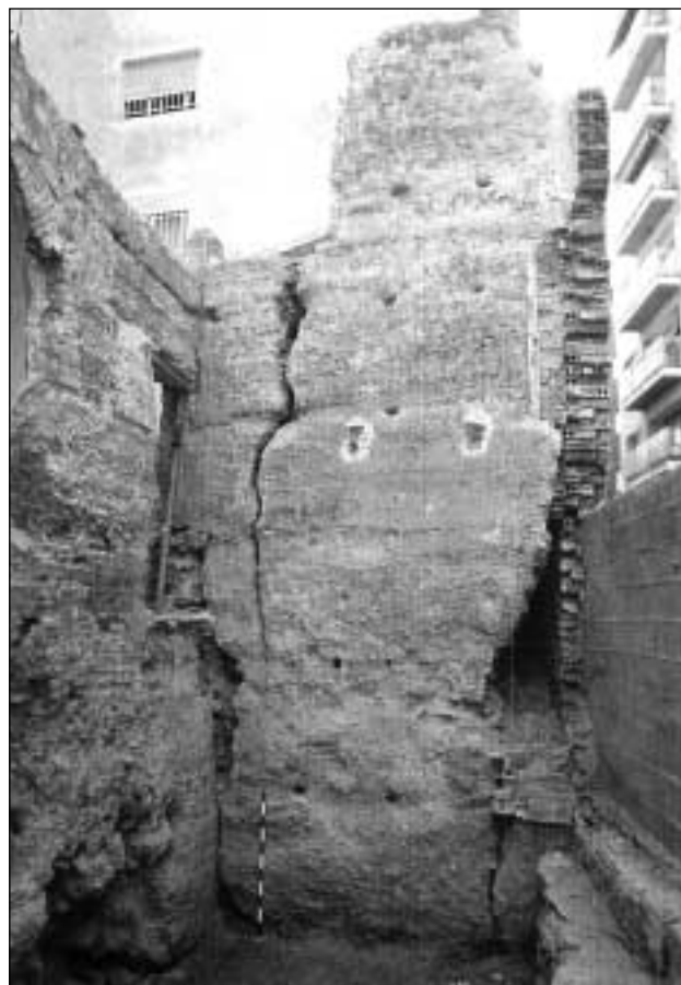
Figura 8. Lateral este de la torre 3.
