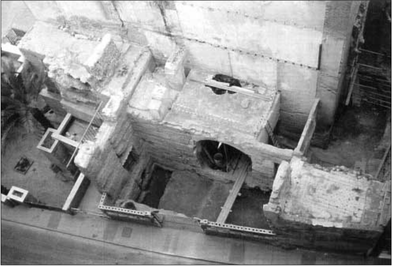
Figura 5. Defensas del tramo de la Capilla de San José. Vista desde el sur.
