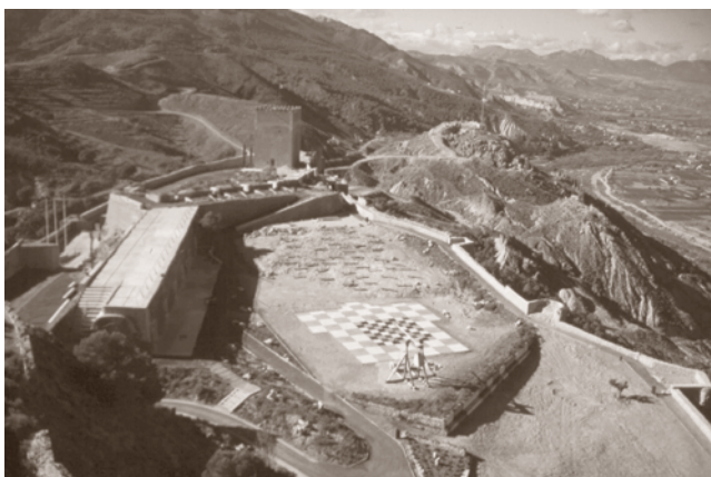
EL CASTILLO DE LORCA CON LAS OBRAS DE ADECUACIÓN AVANZADAS
