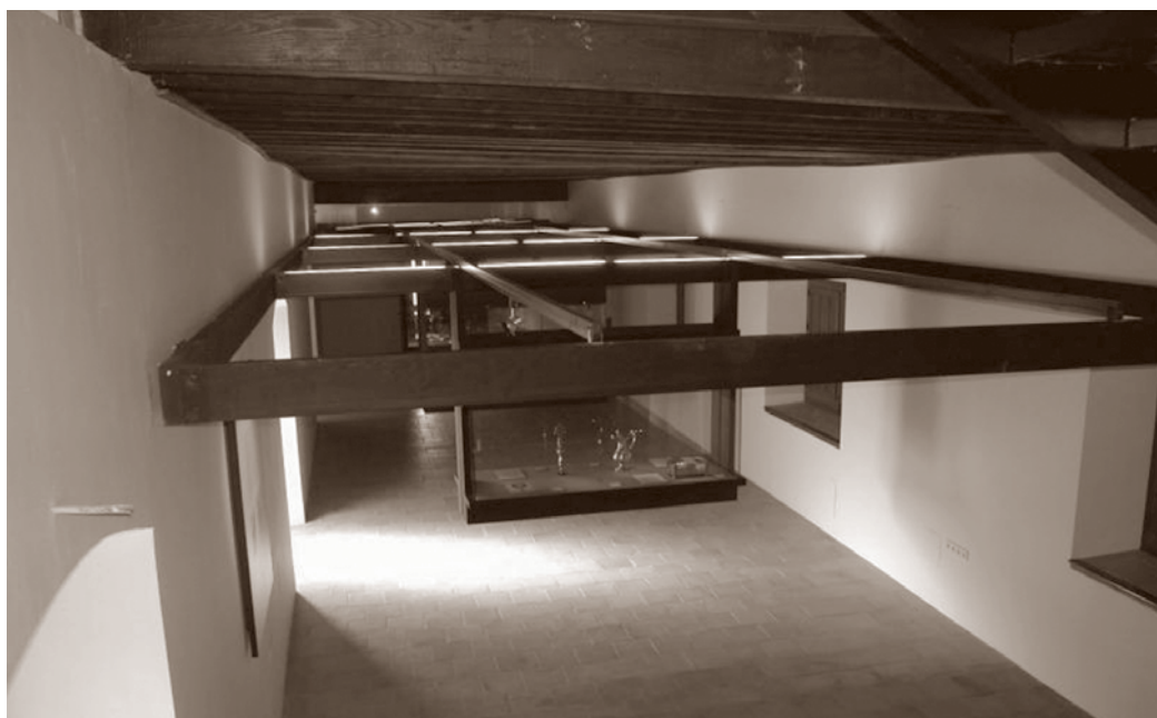
POSTERIOR A LA INTERVENCIÓN
