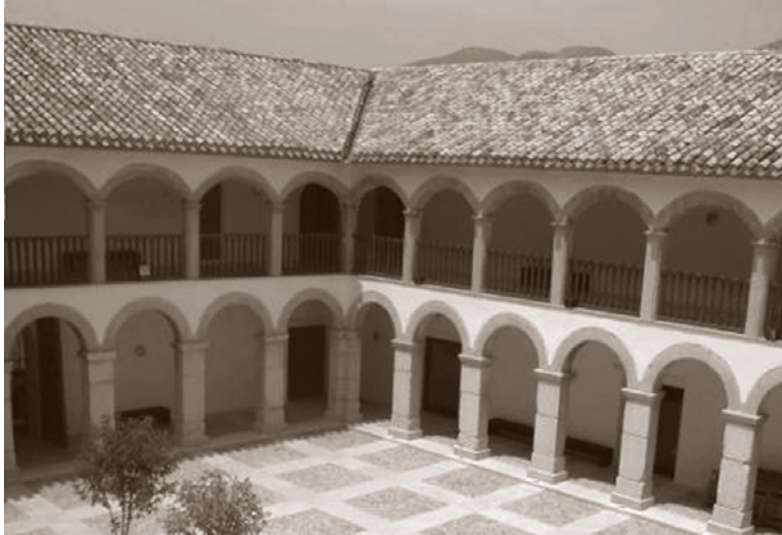
POSTERIOR A LA INTERVENCIÓN
