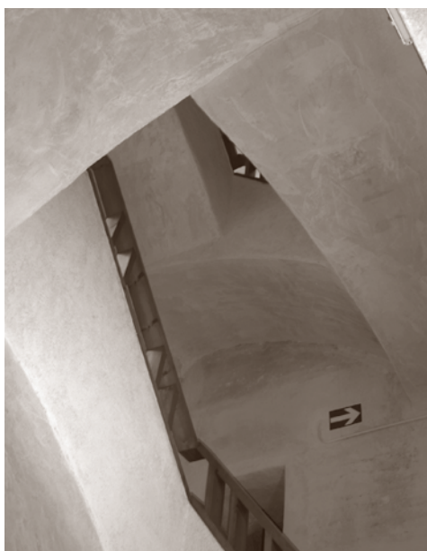
VISTA INFERIOR DE LA ESCALERA. POSTERIOR A LA INTERVENCIÓN
