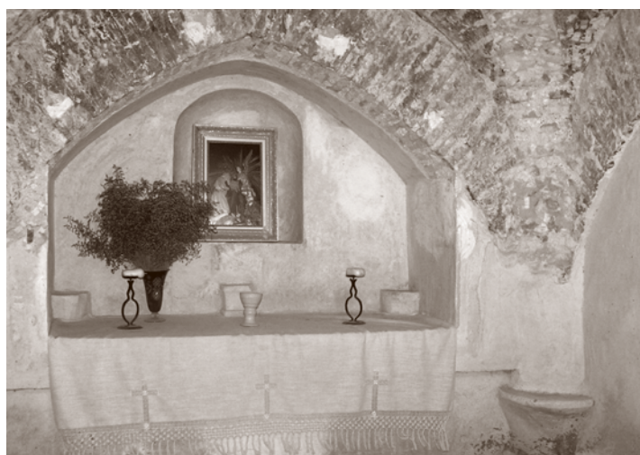
SALA DE LA CAPILLA. ANTERIOR A LA INTERVENCIÓN
