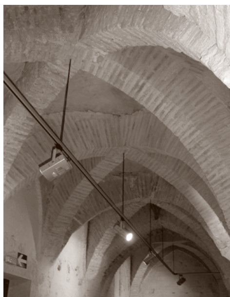
ILUMINACIÓN DE LAS SALAS DE PLANTA BAJA. POSTERIOR A LA INTERVENCIÓN
