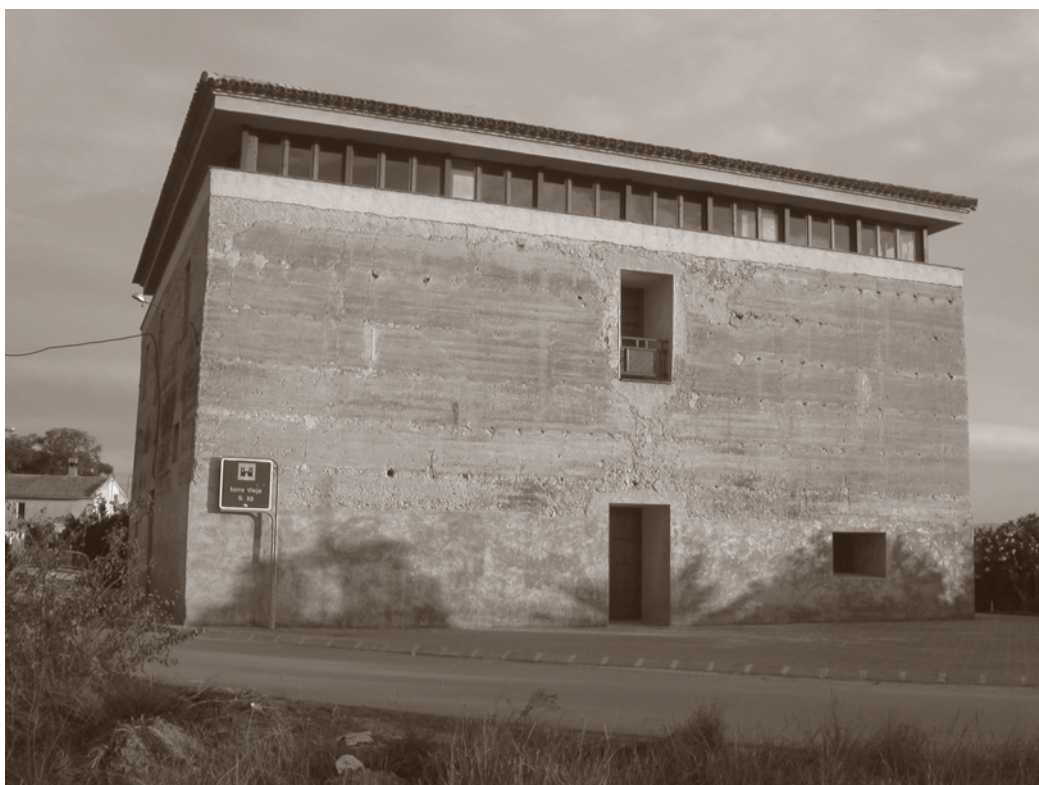
FACHADA NOROESTE. POSTERIOR A LA INTERVENCIÓN
