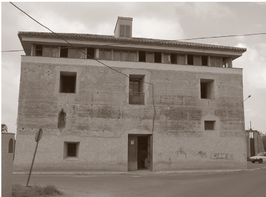
FACHADA PRINCIPAL: NORESTE. ANTERIOR A LA INTERVENCIÓN
