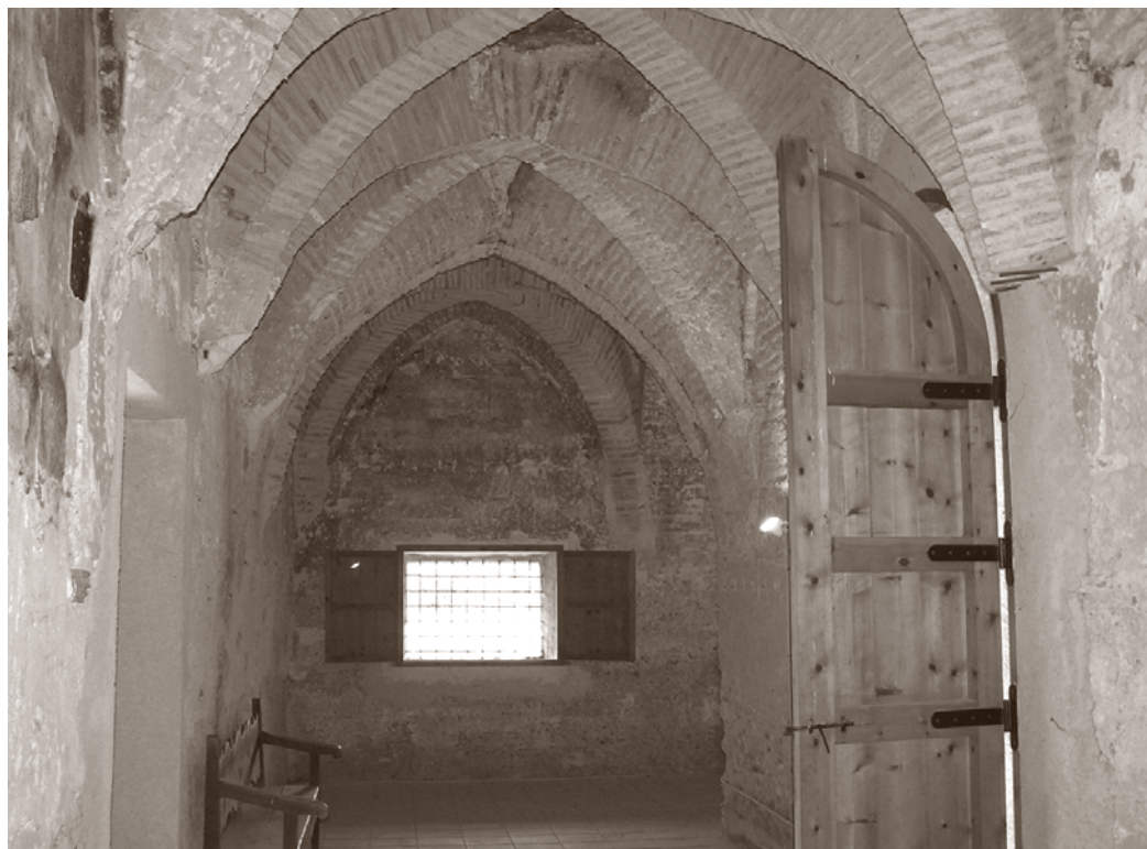
UNA DE LAS SALAS EN PLANTA BAJA. SE PUEDEN VER LAS BÓVEDAS DE CRUCERÍA, SOBRE ARCOS DE LADRILLO. ANTERIOR A LA INTERVENCIÓN
