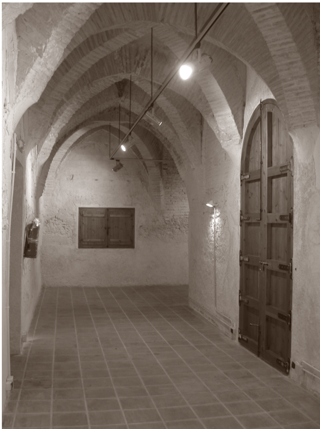
INTERIOR. PLANTA BAJA. POSTERIOR A LA INTERVENCIÓN
