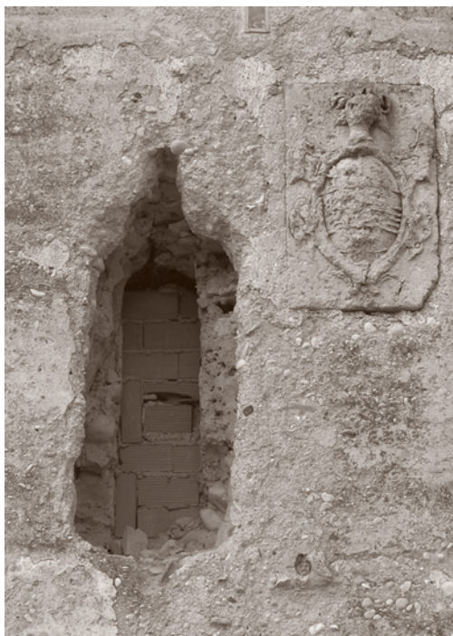
ANTERIOR A LA INTERVENCIÓN
