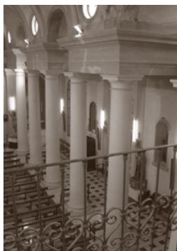
ANTERIOR A LA INTERVENCIÓN. NAVE DE LA EPÍSTOLA
