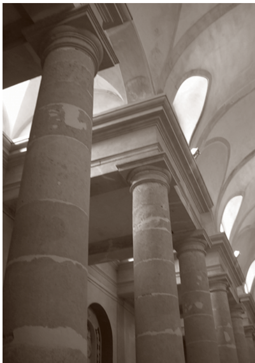
NAVE DEL EVANGELIO. ANTERIOR A LA INTERVENCIÓN
