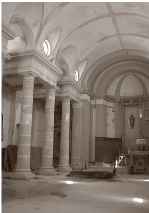
CAPILLA MAYOR. ANTERIOR A LA INTERVENCIÓN
