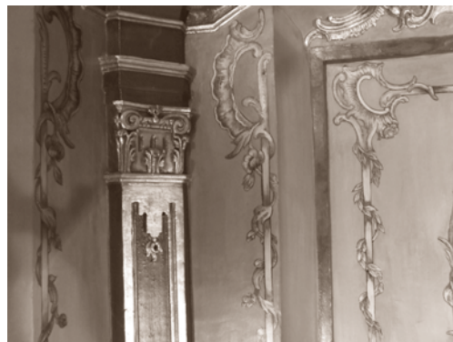
PILAstra CAJETEADA DE ESQUINA, RESTAURADA Y DORADA CON PAN DE ORO
