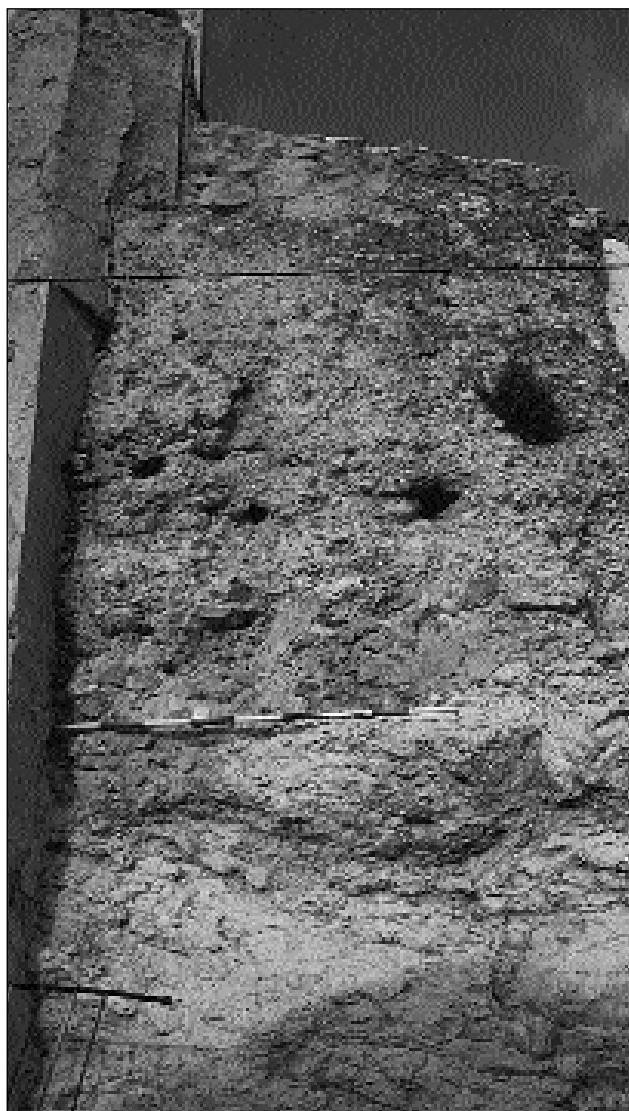
Torre n.º 1 de Sta. M.ª Magdalena, perteneciente al recinto islámico de Cehegín.
