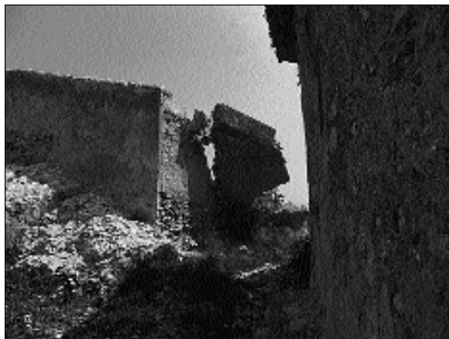
Demolición de una vivienda en la Barriada del Pozo (Cehegín).
