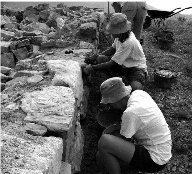
Lámina 5. Trabajos de consolidación en los bastiones del antemuro del castellum .
