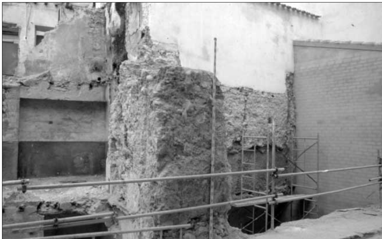
Foto 2: Puerta de Santa Ana. Estructuras murales.
