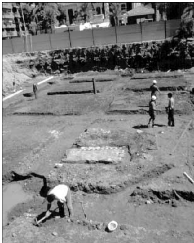
Vista general del desfonde, en el centro la plataforma n.º 1.
