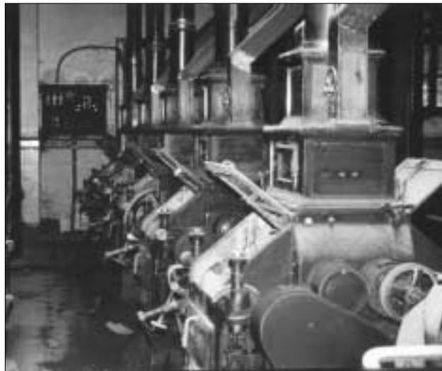
Lámina 4. Planta baja de la fábrica de harinas, vista de los molinos de cilindros
