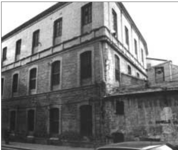
Lámina 3. Vista de la fachada del edificio a la calle Prolongación Hernández del Águila
