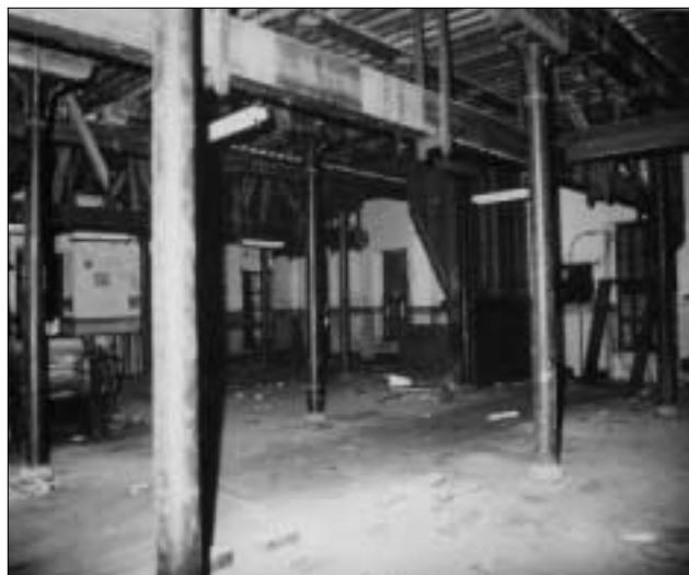
Lámina 10. La planta baja tras la salida de la maquinaria
