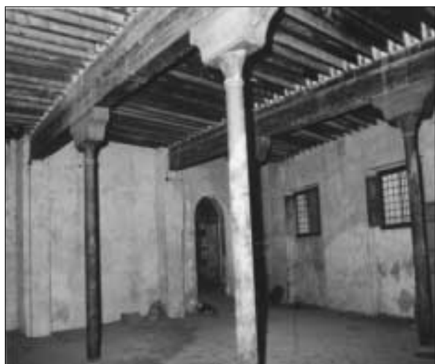
Lámina 11. La planta primera tras la salida de maquinaria
