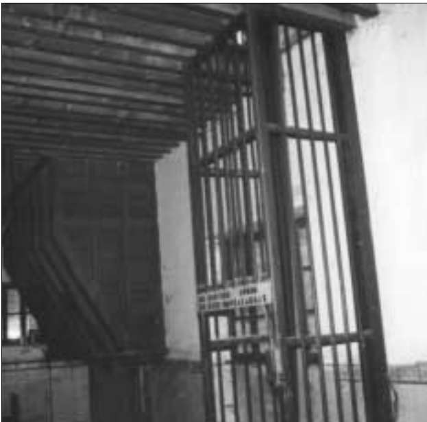
Lámina 6. Planta baja, vista del elevador
