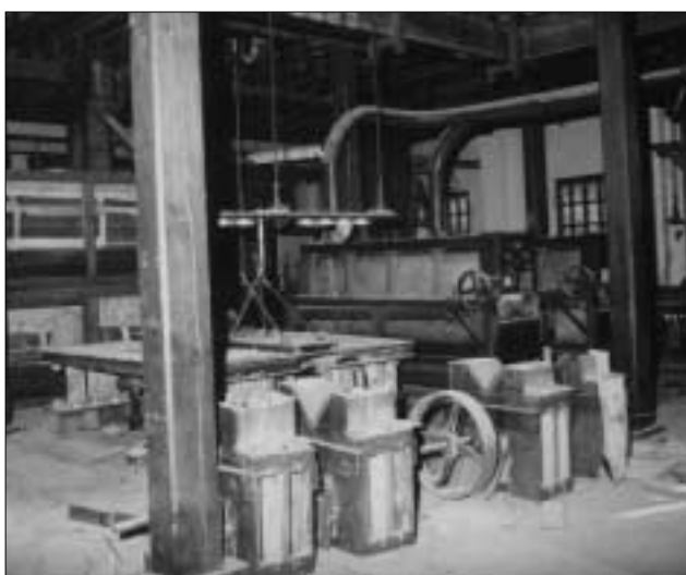
Lámina 9. Vista de maquinaria, vista de cepilladora y cernedor plano o Plansichter
