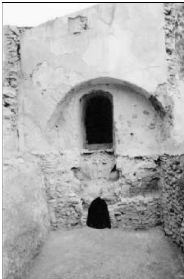
Horno de tinajas del Centro Tecnológico de Artesanía. Boca y porche del cenicero.
