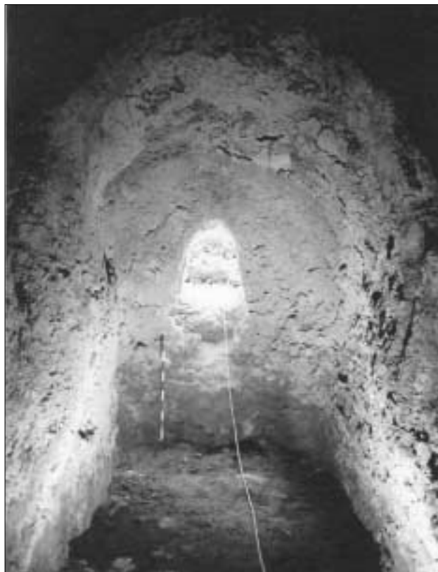
Horno de tinajas del Centro Tecnológico de Artesanía. Boca y porche del cenicero.
