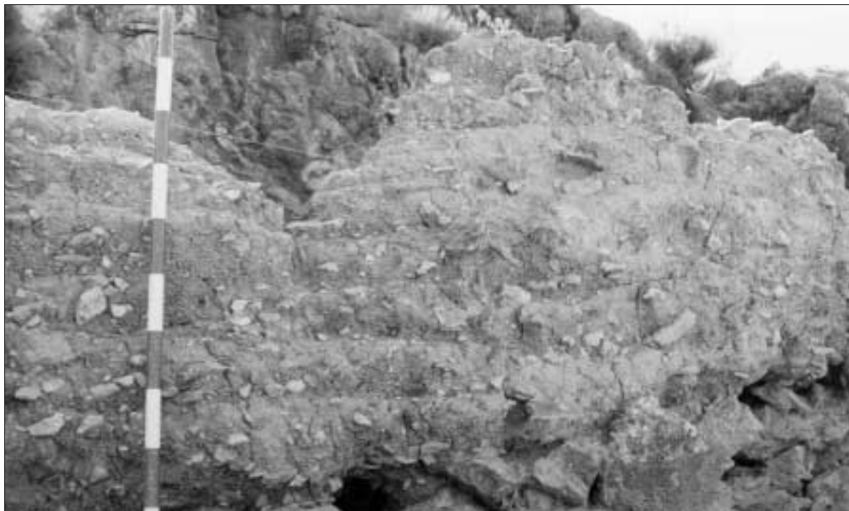
Lámina 10. C-4. Cara externa de la muralla.
