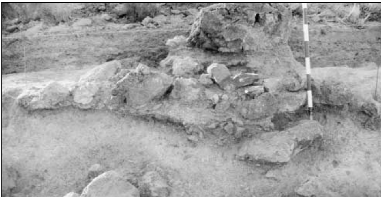
Lámina 7. C-1. Detalle del alzado del zócalo de cimentación.
