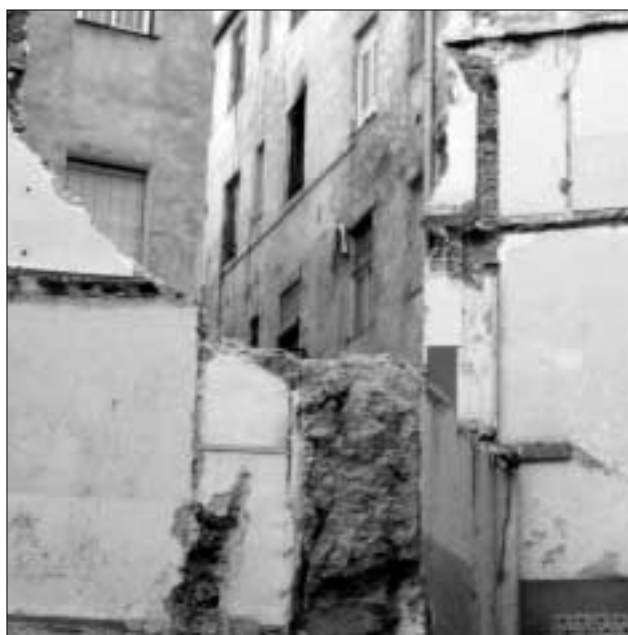
Lámina 3. Sección de la muralla conservada como medianería. Obsérvese el tapial calicastro y el adarve fosilizado (prolongación de la calle Brujera) como patio de luces.
