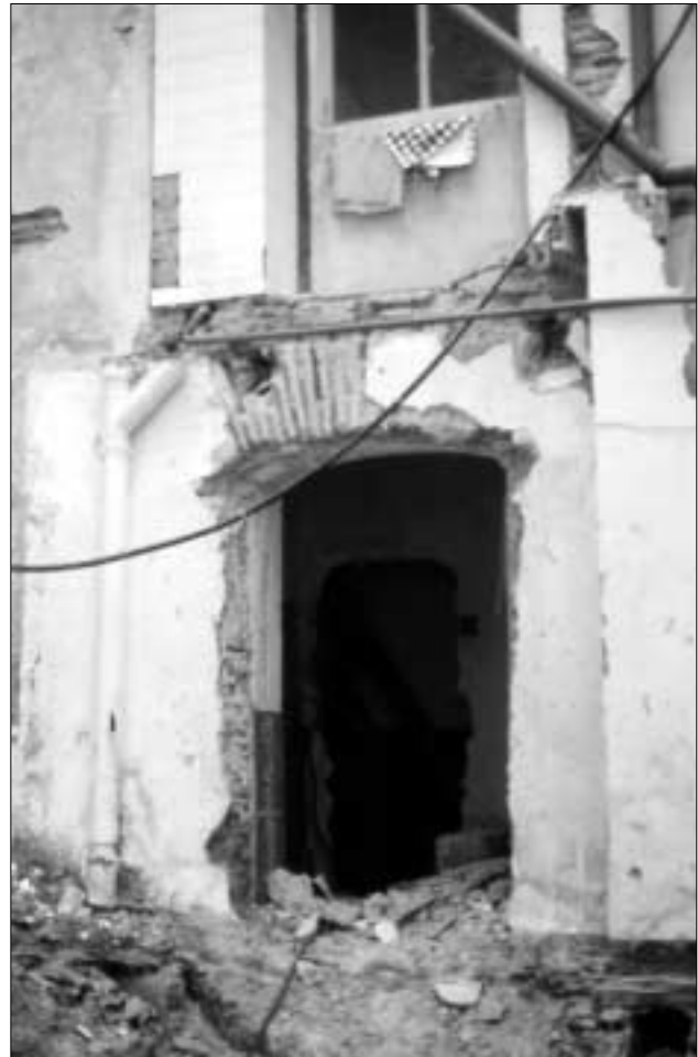
Figura 13. Detalle de uno de los arcos adintelados documentados en el solar de Sagasta (finales del siglo XVII).
