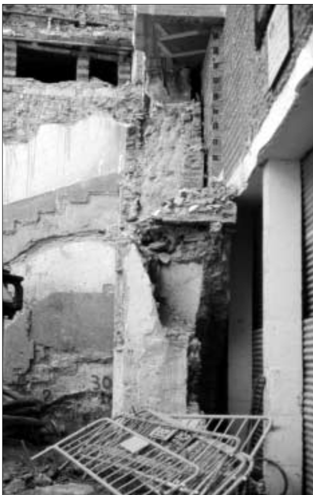
Lámina 1. Sección de la muralla donde se aprecia el forro exterior del tapial calicastro. Solar de la calle San Nicolás (siglos XII-XIII).
